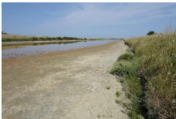
Figure 18. Berge fortement érodée (état considéré comme mauvais), présentant seulement quelques fragments de végétation halophile.
