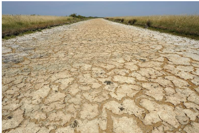
Figure 20.b. Tapis sec d'algues mortes non évacué, recouvrant le substrat.
